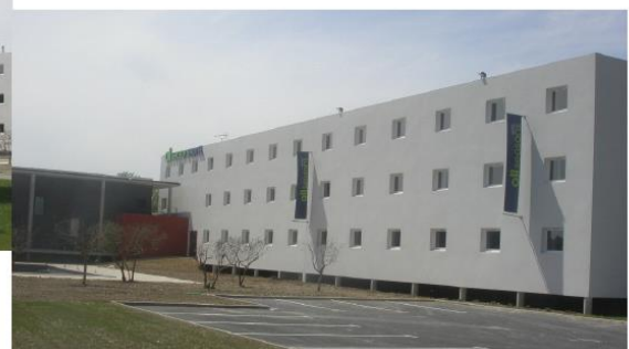
Exemple de constructions sur pilotis. C'est un bon moyen pour limiter l'impact d'imperméabilisation des stationnements. Les sols en pavés participent aussi à la perméabilité du sol.
