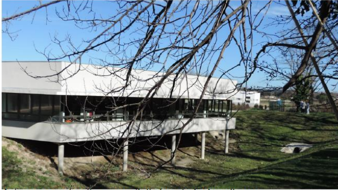
Avignon, constructions sur pilotis les pieds dans l'eau. Non loin un vaste plan d'eau exhaure les terrains
