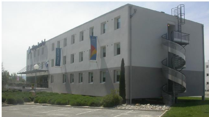
A Pertuis, adaptation des constructions au risque d'inondation par transparence hydraulique, micro-pilotis et plancher RDC surélevé.
