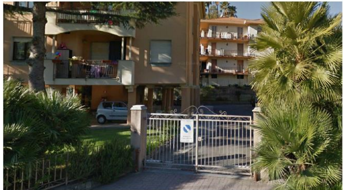
Exemple de constructions sur pilotis. C'est un bon moyen pour limiter l'impact d'imperméabilisation des stationnements. Les sols en pavés participent aussi à la perméabilité du sol.
